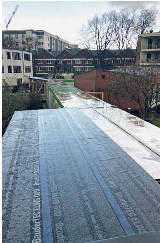
Blick auf den Containergang
