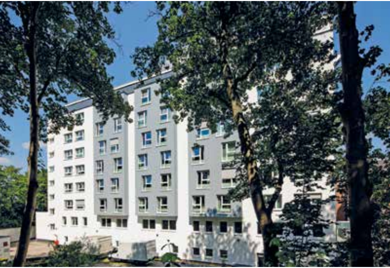
Die „Rückseite“ des Hauses, zum Alten Militärring weisend
